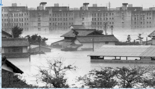
昭和51年(1976)9・12豪雨災害「安八水害」(安八町)
