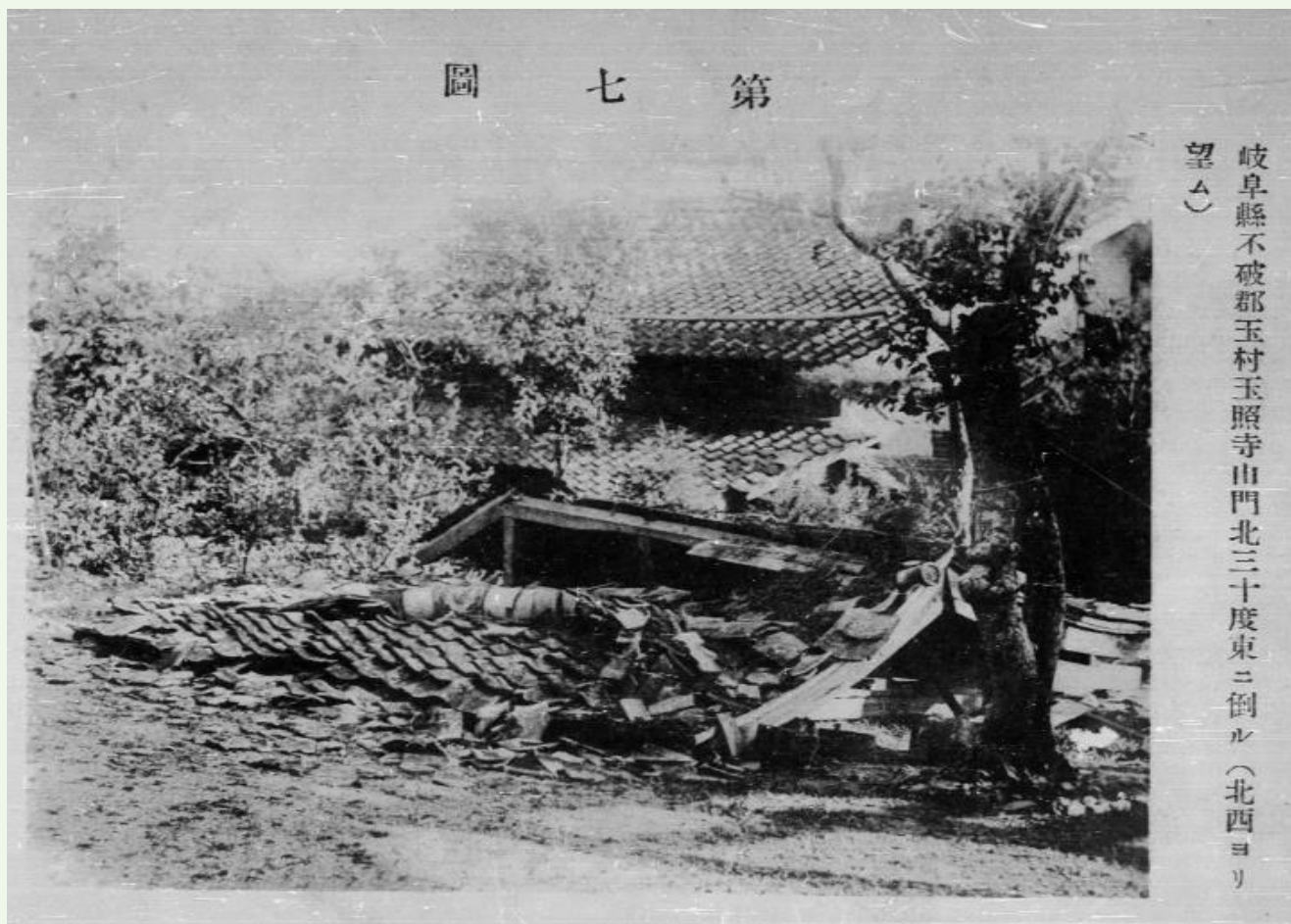
不破郡玉村玉照寺山門倒壊の様子 (岐阜地方気象台提供マイクロフィルム「濃尾大地震災害写真」 -岐阜県不破郡玉村玉照寺山門北三十度東ニ倒ル)
